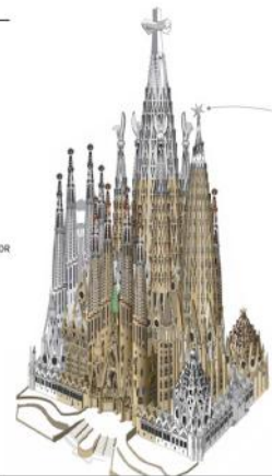
Torre de la Virgen María (138 metros) Fue la primera torre que comenzó a crecer, en diciembre del año 2016. Tiene colocados 18 de sus 19 niveles y llega a los 110,65 m.
